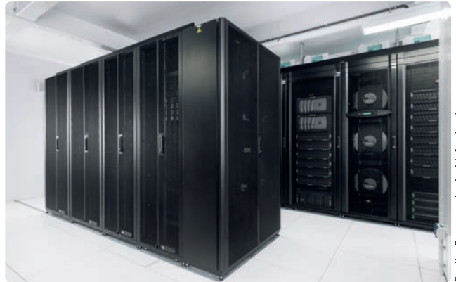
Racks mit Servern und Switches im neuen Rechenzentrum der WISAG (Abb. 3).
