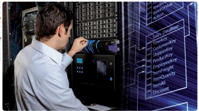
Ein aktives Vermeiden von Bränden kommt auch beim Auslösen der Anlage ohne Stromlosschalten der IT-Komponenten aus und sorgt so für durchgängigen Betrieb (Abb. 2).
