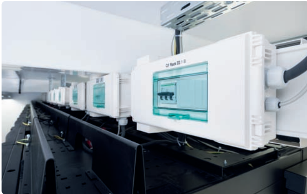
Detailansicht der Stromversorgung an der Oberseite der Racks (Abb. 2).
