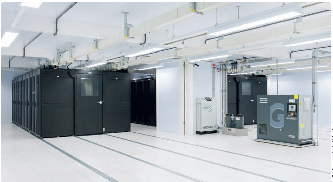
Das neue Rechenzentrum der WISAG mit Warmgangeinhausung (links) und Klimageräten (rechts) (Abb. 1).
