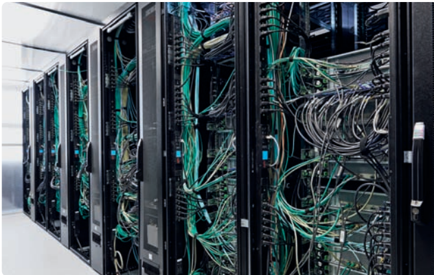
Innerhalb von drei Monaten erfolgte der Umbau des Raumes und der Installation des Rechenzentrums bei der TU Kaiserslautern (Abb. 4).
