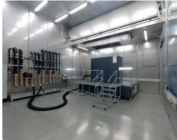
Die Prüfeinrichtung für Klimatechnik bietet zwei separate Klimakammern und vier Konditionierungsanlagen (Abb. 1).
