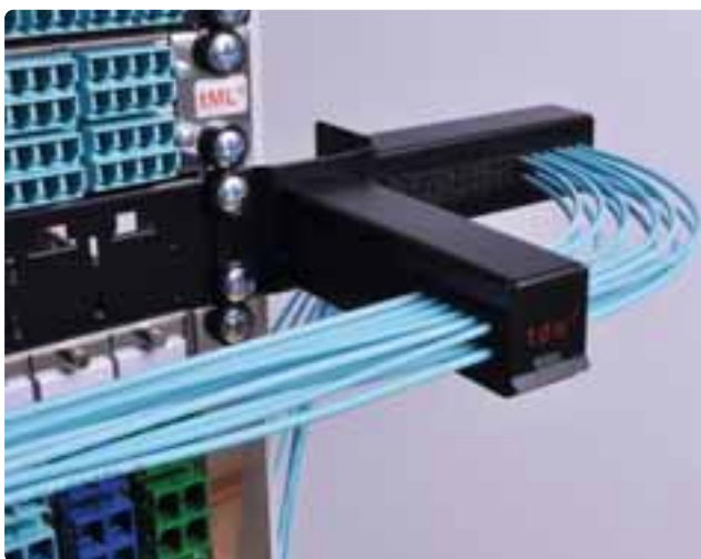
Das modular aufgebaute Verkabelungssystem besteht aus den drei Kernkomponenten Modul, Trunkkabel und Modulträger.
