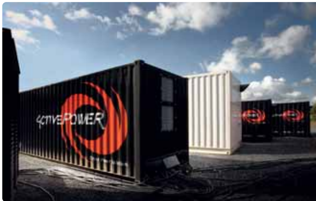
Verpackt im Container lässt sich die komplette Strominfrastruktur binnen 24 Stunden anschließen (Abb. 5).
