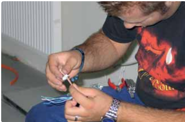
Das Konfektionieren mit dem GG45-Stecker erfordert genaues Arbeiten (Abb. 3).
