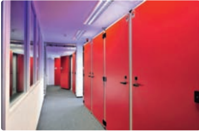
Direkt an jedem Modulsafe befinden sich flüssigkeitsbasierte LCPs von Rittal mit bis zu 30 kW Kälteleistung (Abb. 5).
