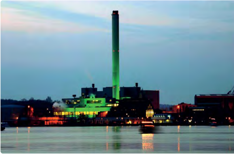
Platz für ein Rechenzentrum mit 200 Quadratmetern bietet das Verwaltungsgebäude der Stadtwerke Flensburg (Abb. 1).
