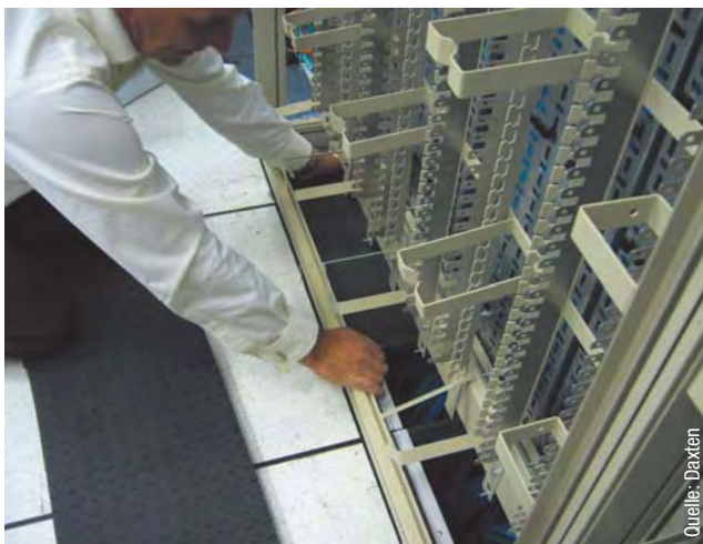
Die ziehharmonikaartige Abdichtung für Kabelführungen umschließt luftdicht die durch den Doppelboden geführte Verkabelung und verhindert so Bypass-Kühlluftströme und thermische Ungleichgewichte im Rack (Abb. 2).
