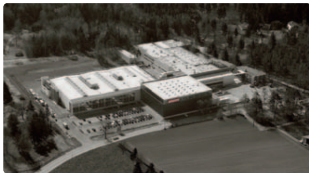
Hilti stattet sein Werk für Kunststofftechnik in Nersingen mit einer zukunftssicheren physikalischen Infrastruktur aus (Abb. 1).
