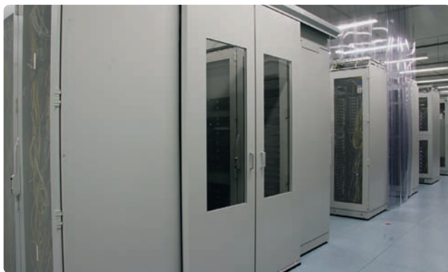
Die Einhausung reduziert die Temperaturschwankungen vor den Serverracks von fünf bis sechs auf ein bis zwei Grad Celsius (Abb. 1).
