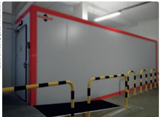
Die EN-1047-2-zertifizierte Sicherheitszelle in der Tiefgarage des CENIT-Gebäudes in der Stuttgarter Industriestraße beherbergt eines der beiden Rechenzentren am Standort.
