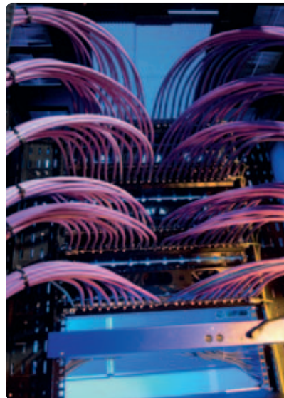
Kabeloptionen für 10 Gbit/s umfassen geschirmte (F/UTP) und ungeschirmte (UTP) Kabel der Kategorie 6A/ Klasse EA, sowie vollgeschirmte (S/FTP) Kabel der Kategorie 7A/ Klasse FA (Abb. 3).
