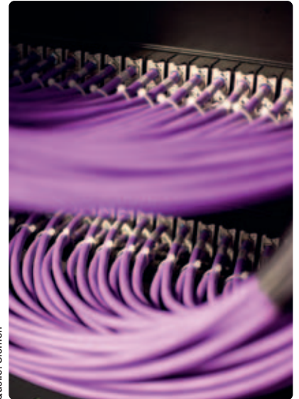
Kat.-7A/ FA-Kupferkabel in der Rechenzen- trumsumgebung (Abb. 2)
